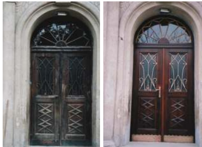
Obnova vhodnih vrat Oš Mežica
